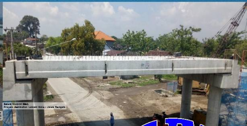
Segmen Hot Mix Proyek Jalan Tol KLSM (Krian-Lugundi-Samar-Munyar) Grande - Jawa Timur
